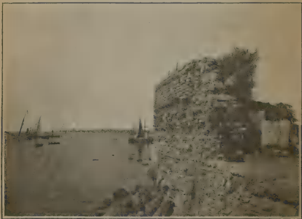
FIG. 2. Mur de la Marmara.
